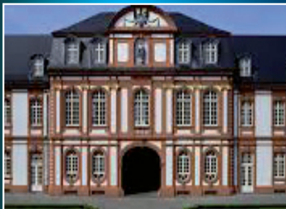
Kulturzentrum Abtei Brauweiler
